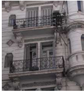
Fig. 64 : Proximité de deux portes-fenêtres (deux par deux), a engendré deux moments de la façade accentués par les balcons. Source : Auteur
