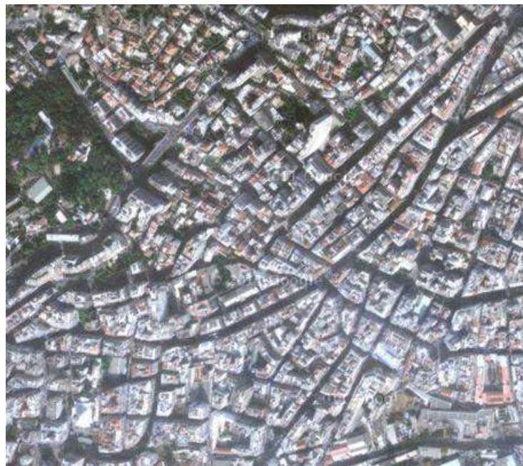
Fig. 2 : Photographie satellite de la rue Didouche Mourad (sans échelle). Source : Google earth.
