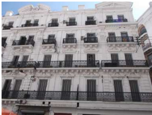
Fig. 27 : Avec un garde-corps continu au premier étage, c'est l'esprit de l'étage noble qui persiste, la pureté des lignes et le retour vers le fronton. Source : Auteur
