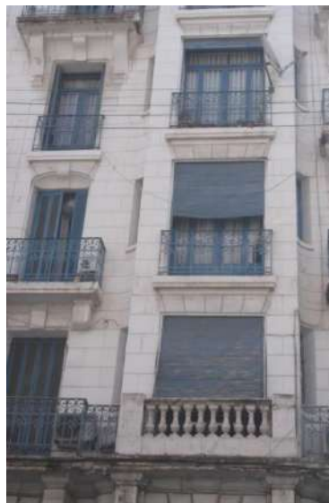
Fig. 28 : Pour le premier étage, garde-corps en balustres, balcon plus large et plus en saillie que les autres (esprit de l'étage noble) Source : Auteur
