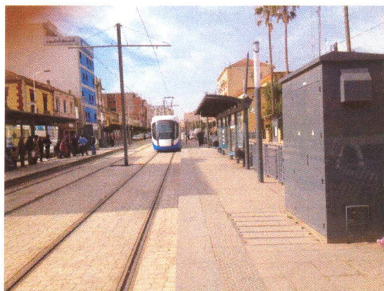
Figure 53: photo de la station du tramway a Bordj El Kiffan
