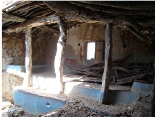
Fig. 97 : La charpente empilée (intérieur d'une maison au village Ait el Kaïd) Source : cliché personnel (Mars 2012)
