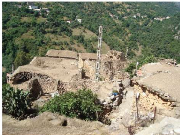
Fig. 99 : Maisons dotées de toits en terre battue. Source : cliché personnel (Mars 2012)
