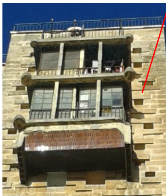
Figure 43 : Encorbellement (photo prise novembre 2016)
