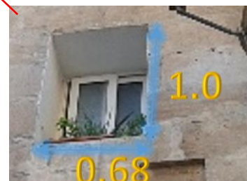
Figure 46 : fenêtre de la cuisine (photo prise novembre 2016)
