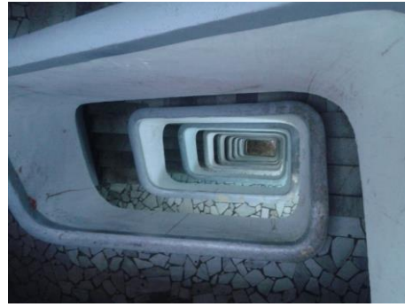
Figure 21 : cage d'escalier (photo prise novembre 2016)
