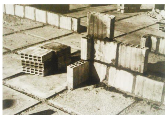
Figure 71 : Pose de brique entre deux marmites (source : CATHERINE SAYEN, 2015, p 46)
