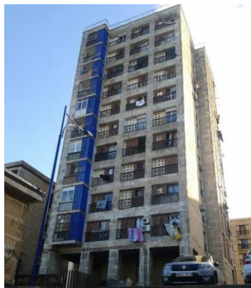
Figure 17 : vue sur le bâtiment côté nord-est (photo prise novembre 2016)
