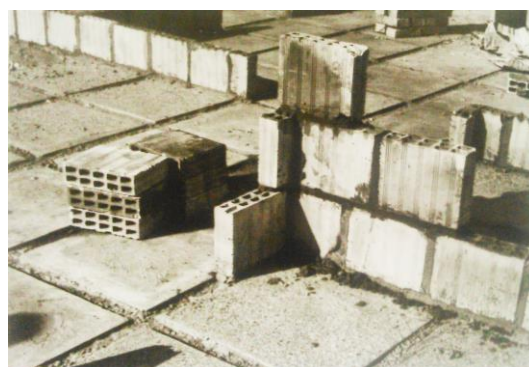
Figure 62 : des briques posées debout (source : CATHERINE SAYEN, 2015, p 46)
