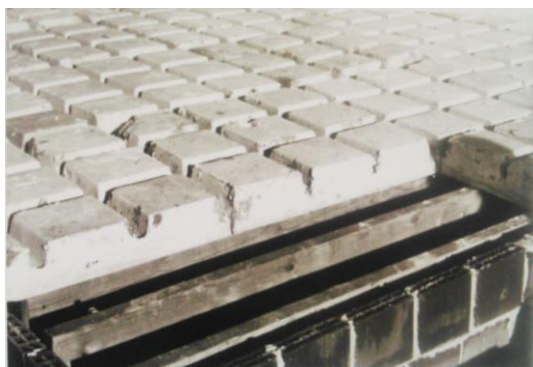
Figure 63 : Plancher a marmites (source : CATHERINE SAYEN, 2015, p 45)
