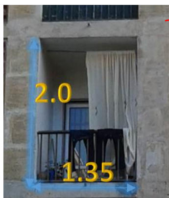
Figure 40 : porte fenêtre du hall (photo prise novembre 2016)
