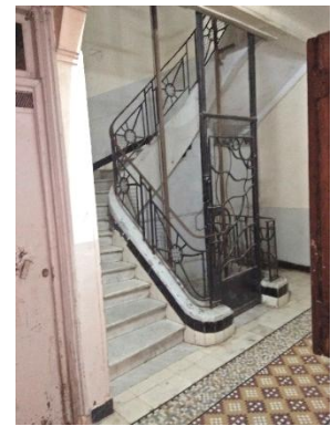
Fig.II.38: Ferronnerie de la cage d'escalier et de l'ascenseur de l'immeuble.
