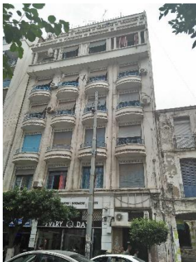
Fig.II.83: façade principale de l'immeuble. Source : Photo de l'auteur, septembre 2018
