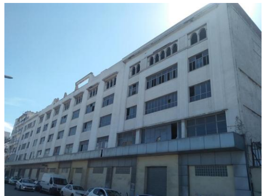
Fig.II.89: Façade principale, Source: Photo de l'auteur octobre 2018
