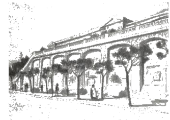
Fig.II.61: Le mur de soutènement de l'université avant l'intervention. Source: Chantiers février 1929
