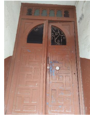
Fig.II.19 : Porte d'entrée de l'immeuble.
