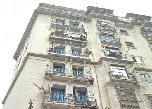
Fig.II.12: Angle en chanfrein entre la façade latérale et la façade arrière.
