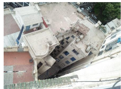
Fig.II.23 : vue sur la une partie de la cour depuis la terrasse de l'immeuble.
