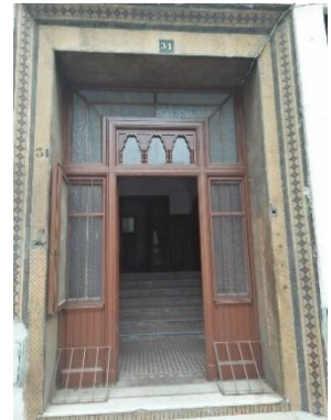
Fig.II.4: Porte d'entrée de l'immeuble 31.
