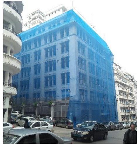
Fig.II.7 : façade de l'immeuble en cours d'embellissement.
