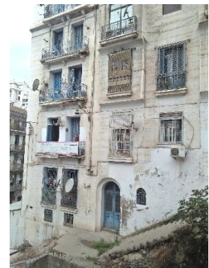
Fig.II.14: Entrée secondaire des niveaux inférieurs.
