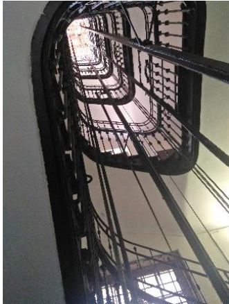
Fig.II.55: Cage d'escalier de l'immeuble.
