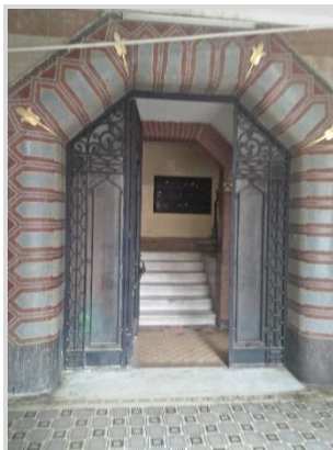
Fig.II.43: Porte d'entrée des logements.
