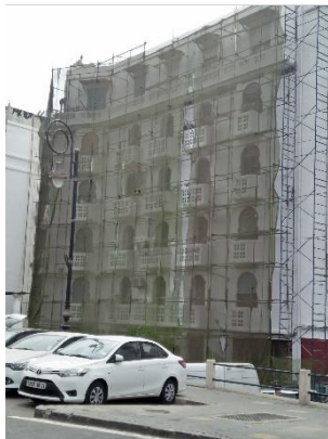
Fig.II.15 : Façade principale de l'immeuble après travaux d'embellissement. Source : photo de l'auteur Octobre 2018
