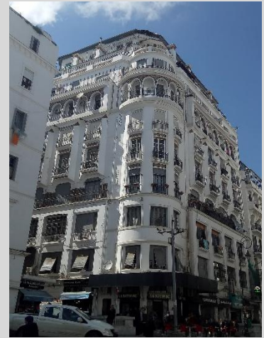
Fig.II.69: Angle de l'immeuble. Source: photo de l'auteur février 2018
