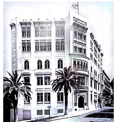
Fig.II.80: Surélévation de l'immeuble, Source: Chantiers juillet 1933 page
