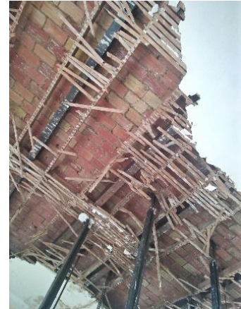
Fig.II.57: composition de la toiture de l'immeuble.
