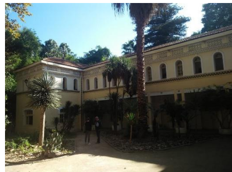
Fig.II.92 : Façade sur la cour d'accès.
