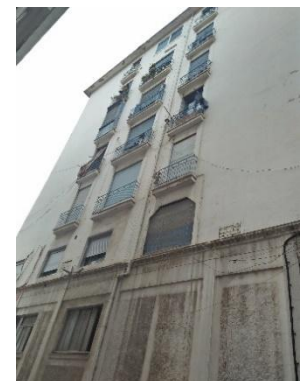
Fig.II.6 : façade latérale de l'immeuble 31.
