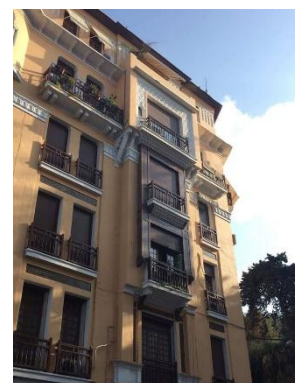
Fig.II.32: Oriel de la façade latérale de l'immeuble 18.
