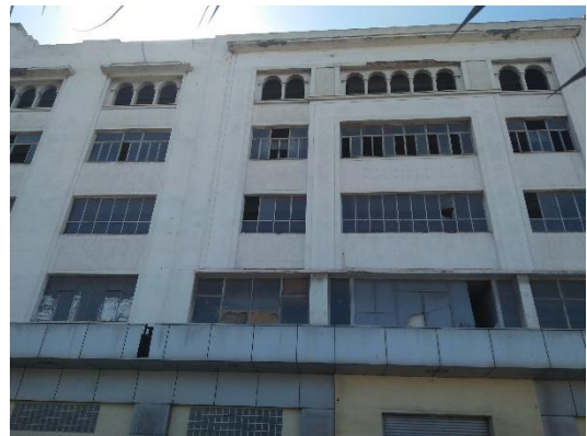
Fig.II.90: Façade principale, Source: Photo de l'auteur octobre 2018
