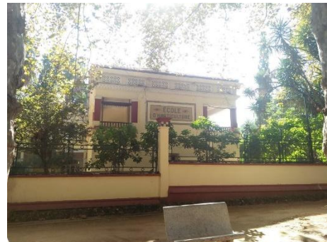
Fig.II.91: Façade du bras du U
