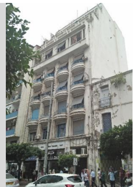
Fig.II.84: façade principale de l'immeuble. Source : Photo de l'auteur, septembre 2018
