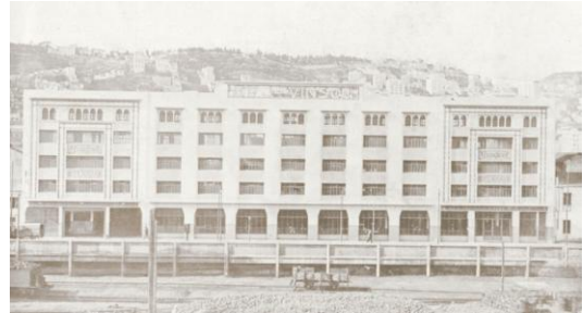
Fig.II. 88: Façade sur la rue Hassiba Ben Bouali, Source: Chantiers mai 1931, p.483
