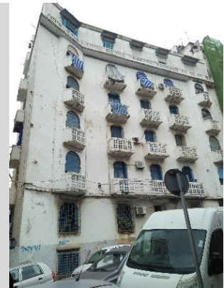
Fig.II.16 : Façade principale de l'immeuble 105 avant les travaux d'embellissement. Source : photo de l'auteur février 2018
