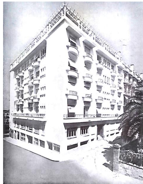
Fig.II.86: Façades de l'immeuble.
