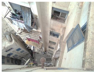
Fig.II.22 : vue sur la une partie de la cour depuis la terrasse de l'immeuble.
