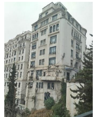
Fig.II.73: Façade sud-est perçu depuis la rampe de Tafoura.
