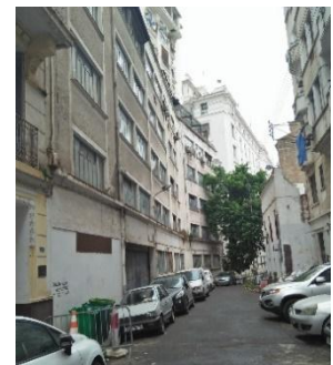
Fig.II.5: Façade sur la rue des frères Alem.
