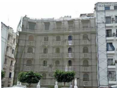
Fig.II.21 : Façade principale de l'immeuble en travaux.
