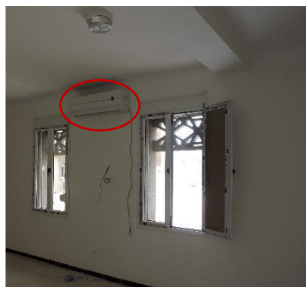
Photo 2: Base de vie de Debdeb, Bloc B3 (A), installation des climatiseurs mono-split, vue d'intérieure. Auteur: AZZOUG Walid.
