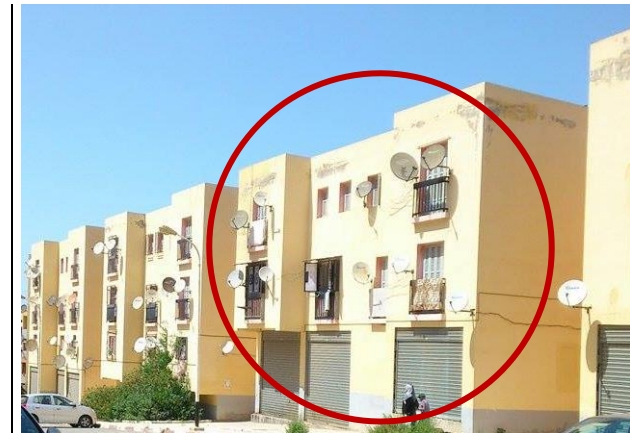
Photo 13: Bâtiment B12. Source: Auteure.
