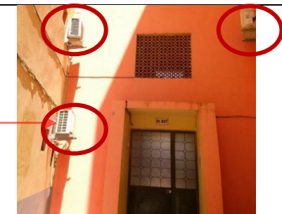
Photo 16: Entrée du bâtiment B07. Source: Auteure.
