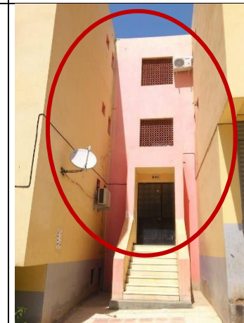
Photo 14: Bâtiment B06. Source: Auteure.
