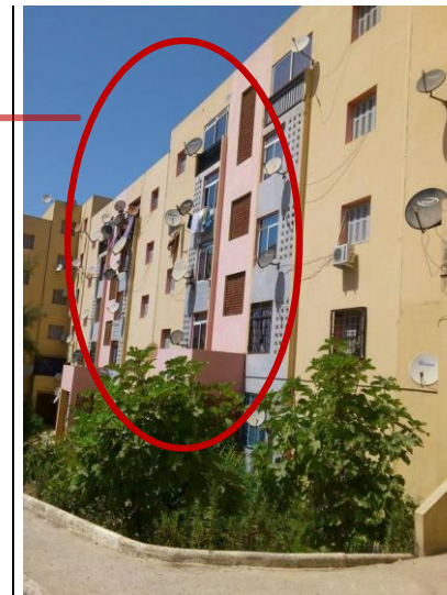
Photo 12: Bâtiment A04. Source : Auteure.
