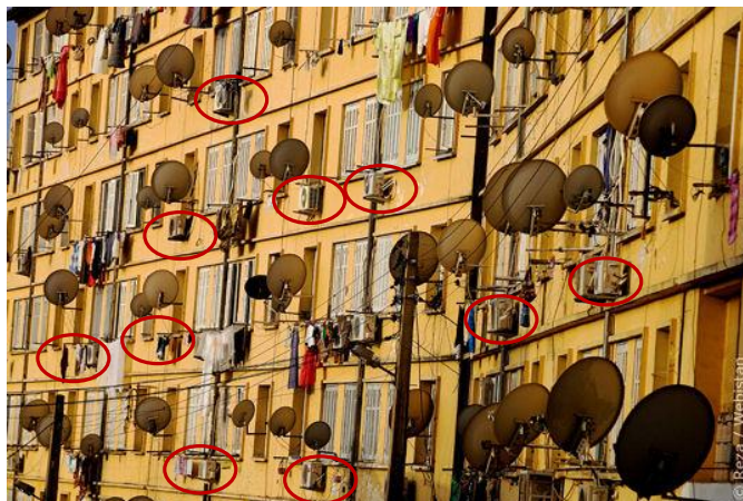
Photo 10: Immeuble d'habitation à Alger Centre. Source : Web.
