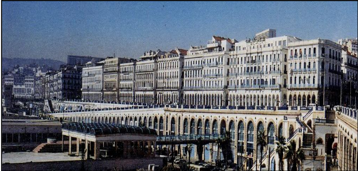
Fig. 1. Façade urbaine, le front de mer d'Alger source: «COHEN J.L., OULEBSIR N., KANOUN Y, Alger, paysage urbain et architectures 1800-2000, Ed. de l'imprimeur, 2003.
