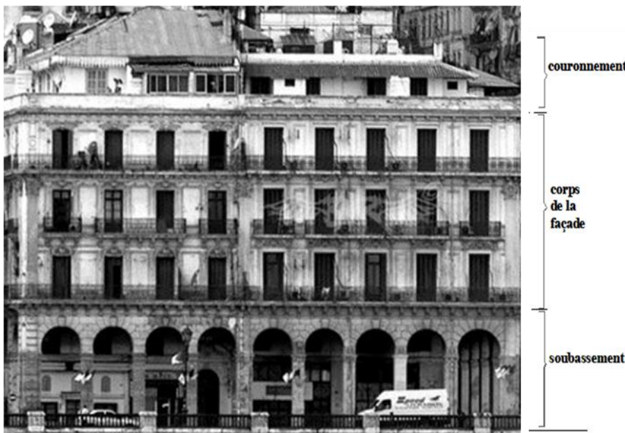
FIG 20 vue en façade sur un des immeubles du boulevard
